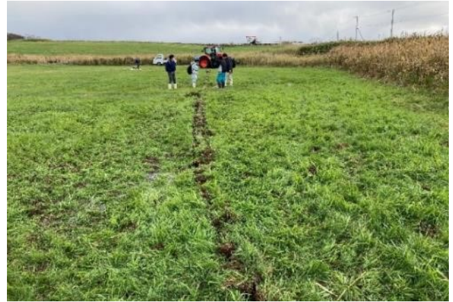
カットドレーン施工後の草地
