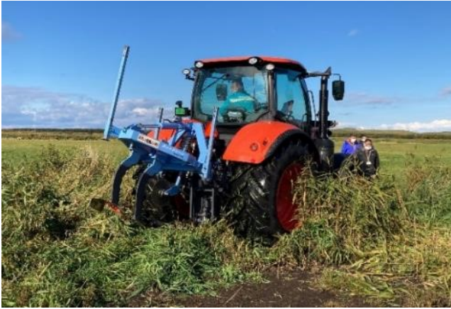
カットドレーン施工の様子
